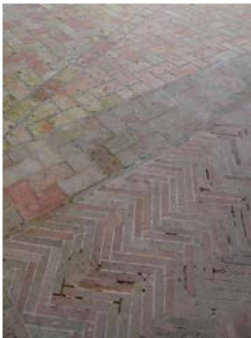
Figura 5. Enladrillado bruto en el pavimento del Patio de la Clavería (fotografía del autor).
