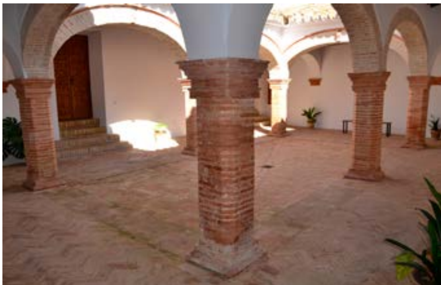
Figura 4. Pilares ochavados de ladrillo del Patio de la Clavería, levantados en 1482 (fotografía del autor).
