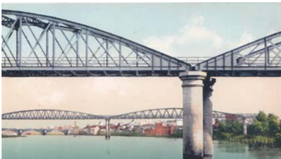
Figura 1. Puente ferroviario de Alfonso XII, puente-pasarela del Agua y puente de Isabel II-Triana. s/f (ca. 1900). Colección particular Marcos Pacheco Morales-Padrón.
