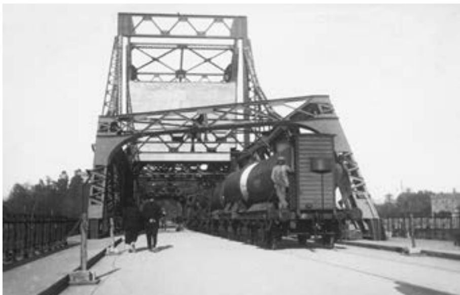
Figura 8. Pruebas de carga del puente de Alfonso XIII, utilizando un tren cisterna de las instalaciones de CAMPSA. Año 1926. Archivo de la Autoridad Portuaria de Sevilla.
