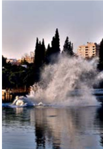
Figura 17. Voladura de los pilares del puente de Alfonso XIII de la margen derecha. Año 1998. Archivo de la Autoridad Portuaria de Sevilla.
