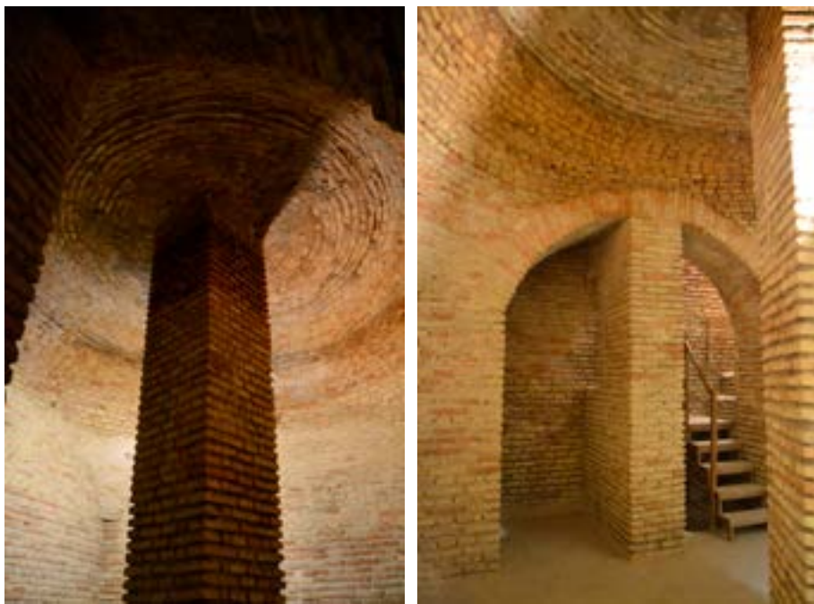
Figura 3. Aljibe construido con ladrillos y reparado en 1478 y 1487 (fotografías del autor).
