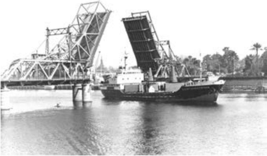
Figura 10. Buque mercante atravesando el puente de Alfonso XIII. s/f (ca. 1960). Archivo de la Autoridad Portuaria de Sevilla.
