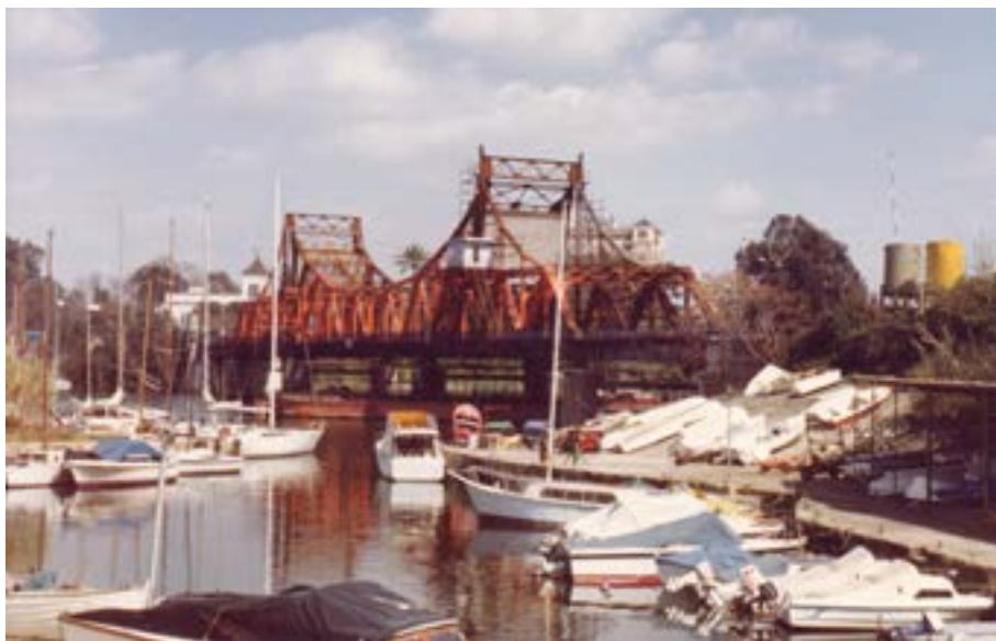
Figura 12. Obras de reparación del puente de Alfonso XIII. s/f (ca. 1983). Archivo de la Autoridad Portuaria de Sevilla.
