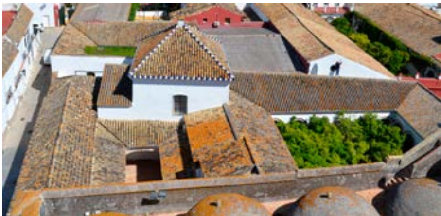
Figura 7. Tejados de los claustros, por primera vez cubiertos en 1492, 1497 y 1499 (fotografía del autor).
