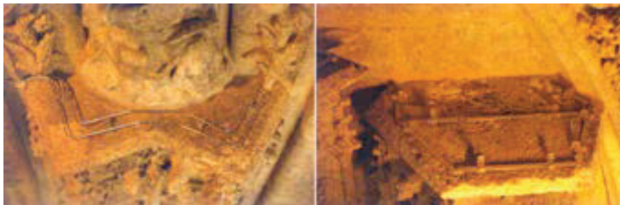
Figura 6 (a y b).- Sistema electrostático instalado en distintos doseles tras la limpieza
