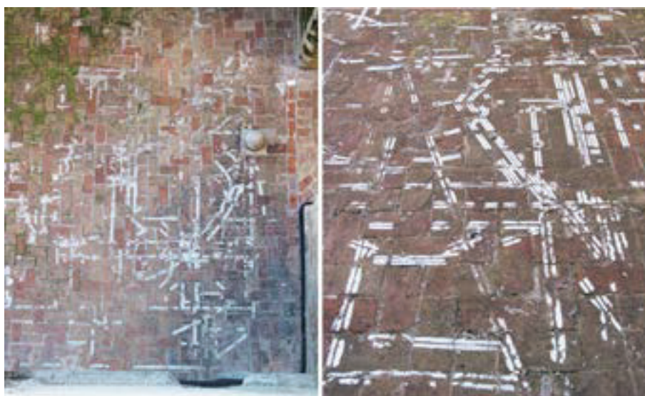
Figura 3 (a y b).- a.- Monteas en la cubierta de la nave sur. b.- Detalle de las monteas.
