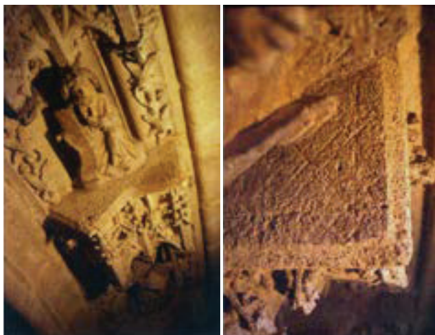
Figura 10 (a y b).- Ejemplos de doseles de base estrella de cuadrados; a.- dosel, b.- punta de estrella del dosel con monteas.
