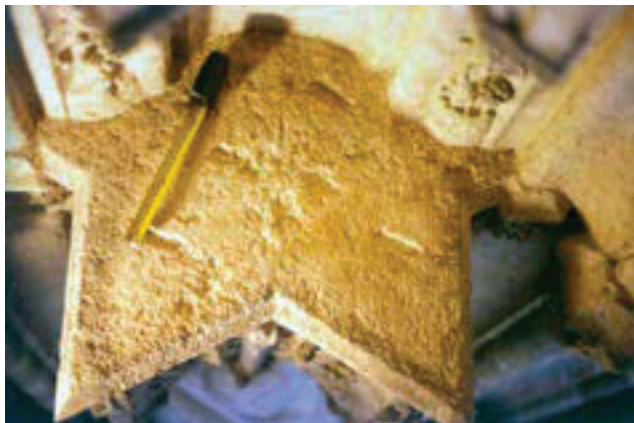
Figura 9.- Ejemplo de doseles de base estrella de triángulos equiláteros
