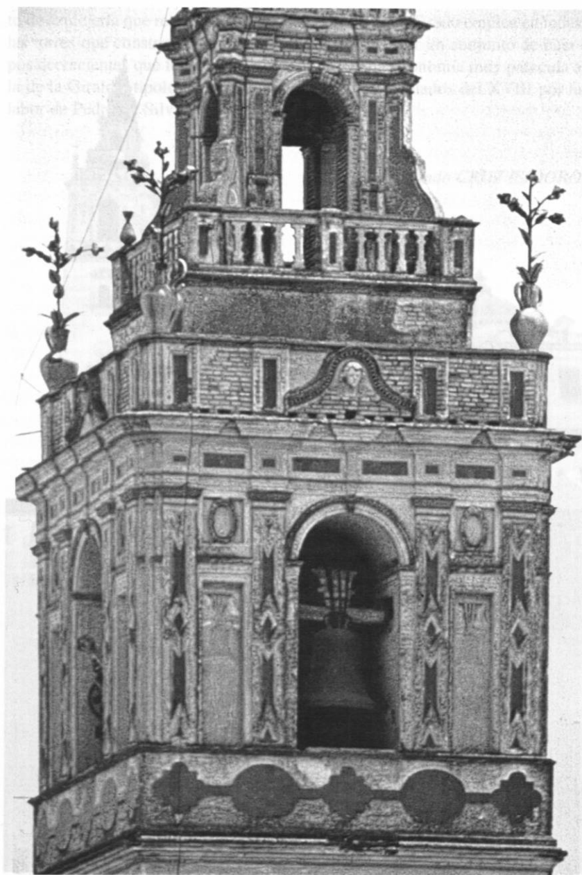
Lám. 2. Detalle del cuerpo de campanas de la torre.
