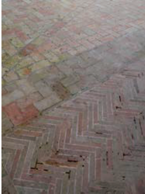
Figura 5. Enladrillado bruto en el pavimento del Patio de la Clavería (fotografía del autor).
