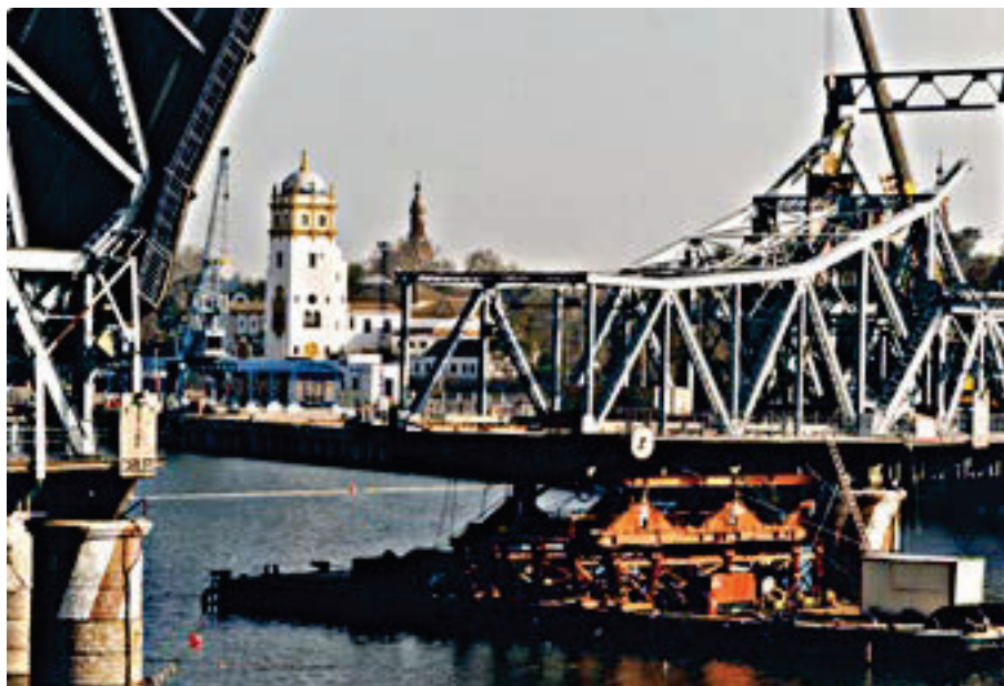
Figura 16. Trabajos de desmontaje y recolocación de los tableros del puente de Alfonso XIII en el muelle de Las Delicias. Año 1998. Archivo de la Autoridad Portuaria de Sevilla.
