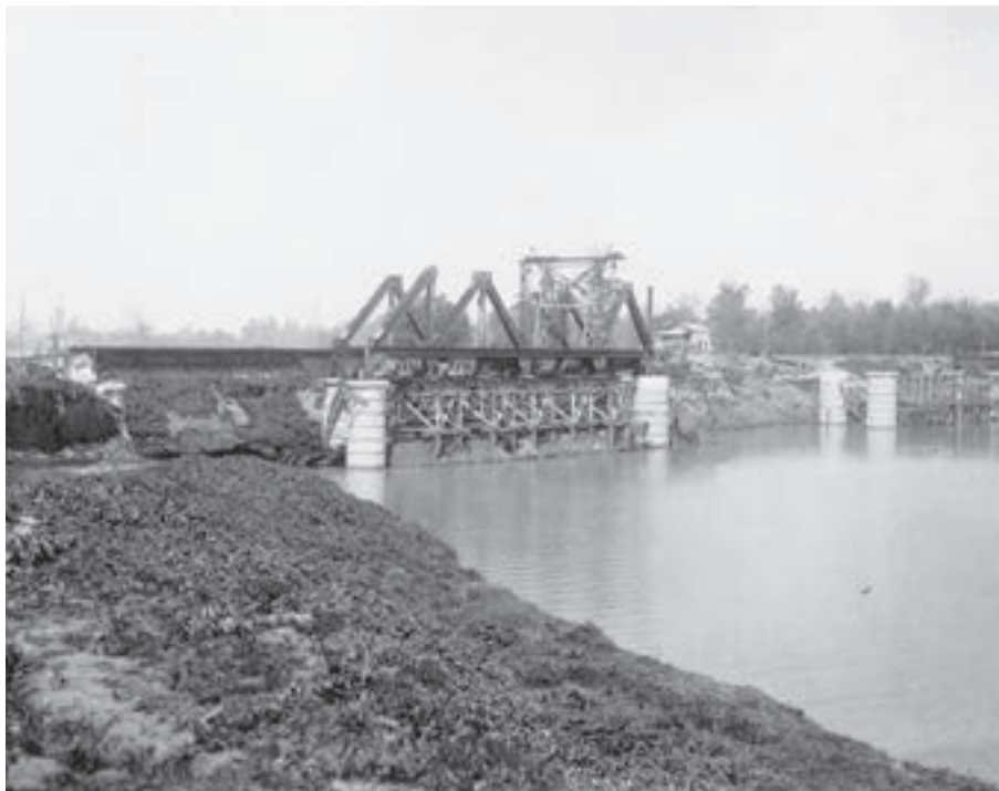
Figura 6. Obras de construcción, en seco, del puente de Alfonso XIII, sobre el terraplén de defensa del canal de Alfonso XIII con la ría del Guadalquivir. s/f . Archivo de la Autoridad Portuaria de Sevilla.
