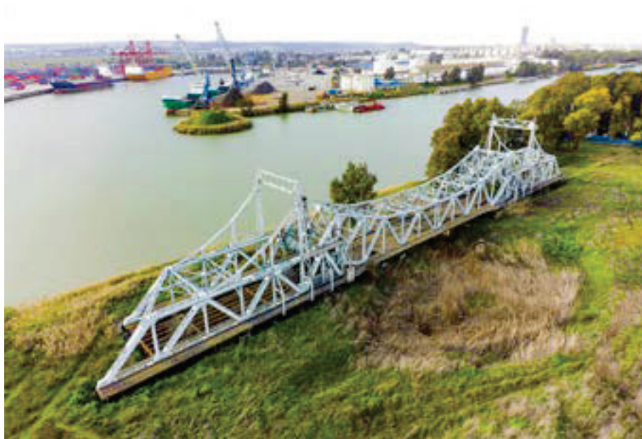
Figura 18. Ubicación actual del puente de Alfonso XIII. Año 2017. Colección particular Marcos Pacheco Morales-Padrón.
