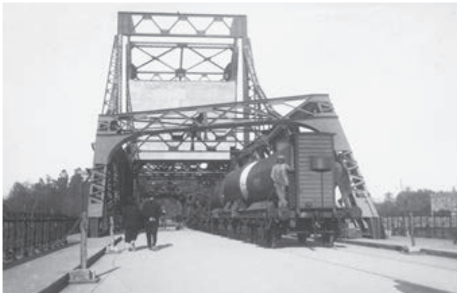
Figura 8. Pruebas de carga del puente de Alfonso XIII, utilizando un tren cisterna de las instalaciones de CAMPSA. Año 1926. Archivo de la Autoridad Portuaria de Sevilla.
