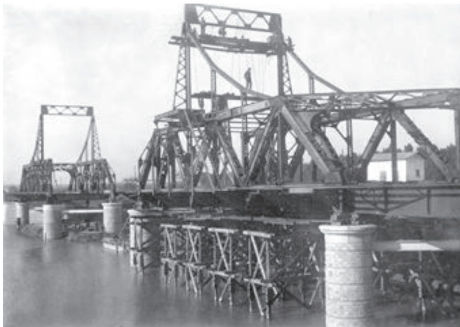
Figura 7. Construcción del puente de Alfonso XIII. s/f. Archivo de la Autoridad Portuaria de Sevilla.
